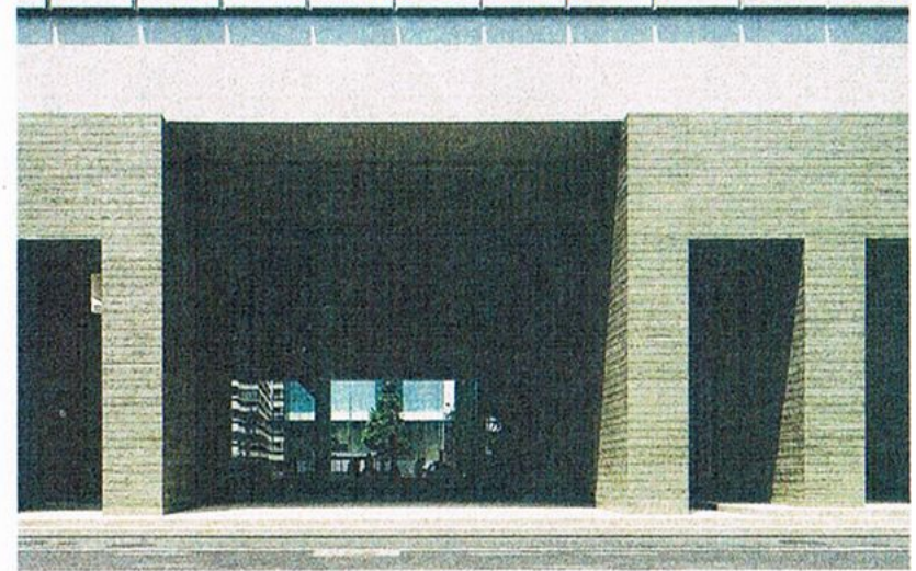
東側より見る。
