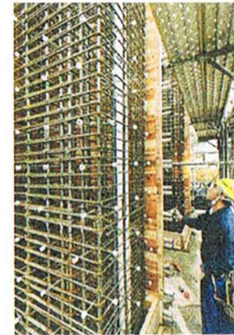
コンクリート打設前。
